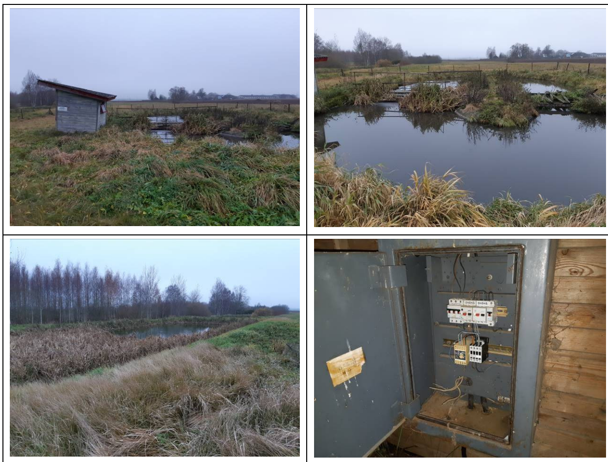
Joonis 16. Kuldre küla reoveepuhasti. Fotod: OÜ Alkranel 07.11.2018.
