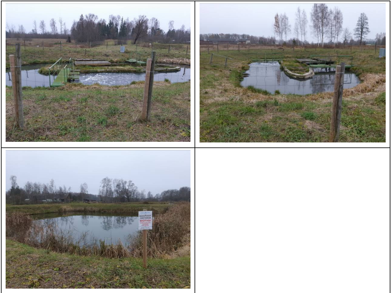
Joonis 10. Vana-Antsla aleviku reoveepuhasti. Fotod: OÜ Alkranel 07.11.2018.
