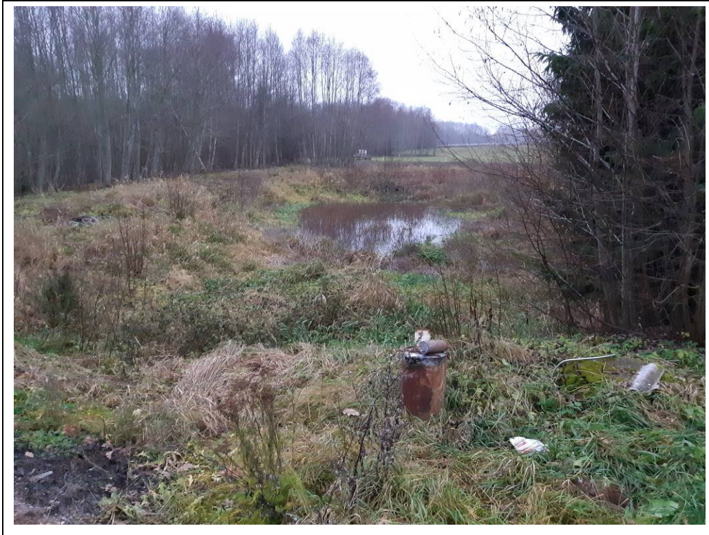
Joonis 22. Visela küla reoveepuhasti. Fotod: OÜ Alkranel 07.11.2018.
