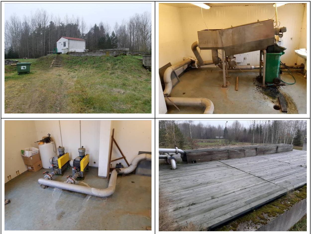
Joonis 6. Antsla linna reoveepuhasti. Fotod: OÜ Alkranel 07.11.2018.
