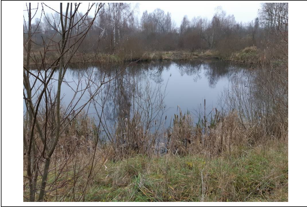
Joonis 20. Vaabina küla reoveepuhasti. Fotod: OÜ Alkranel 07.11.2018.
