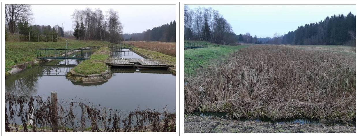
Joonis 12. Tsooru küla reoveepuhasti. Fotod: OÜ Alkranel 07.11.2018.
